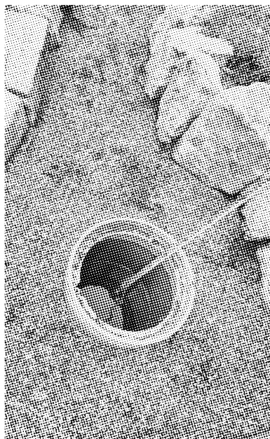
①大島小松川公園の雨庭。土や石によって雨水をゆっくりと地中に浸透させる仕組み
